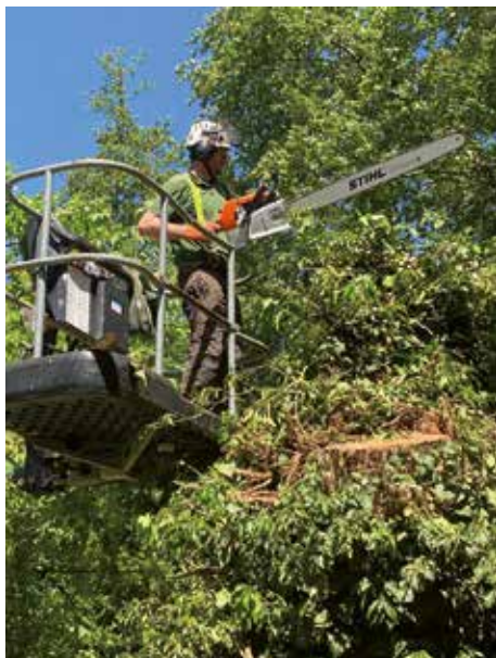
Et une autre est chargée des travaux d'entretien.
