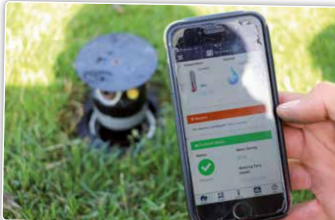
Vorig jaar in de herfst is bij de greens en tees op De Kluizen ook het Toro Hydro Wise-beregeningssysteem met automatische pop-upsproeiers geïnstalleerd.
