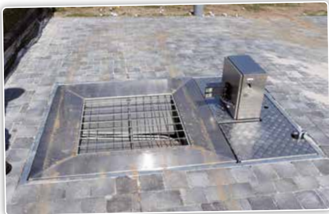
A Alost, le nouveau Drop-pit a également été installé. Le robot ramasseur de balles amène les balles vers un collecteur, où les balles sont ensuite lavées et transportées à travers un système de tubes jusqu'au distributeur.
