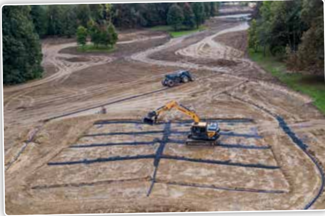
De drainage wordt aangelegd.
