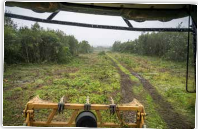
Het terrein moest eerst grondig opgekuist worden.
