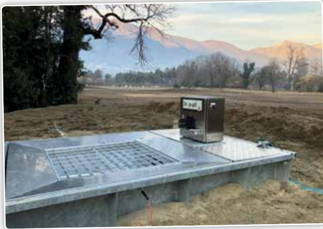
Het basisstation in gegalvaniseerd metaal wordt gemiddeld ongeveer 60 tot 80 cm diep in de grond ingebouwd.
