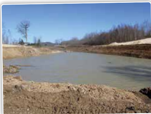
Al het hemelwater wordt afgevoerd naar wachtbekkens om vervolgens gebruikt te worden om te beregenen.
