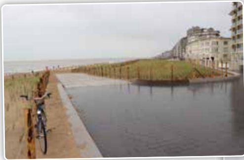
Om te bekijken hoe het beste een grasdijk gebouwd kon worden, reisden het ontwerpteam en de ambtenaren van Middelkerke af naar Nederland en meer bepaald naar Katwijk aan Zee. Op de foto de eerste fase grasdijk.
