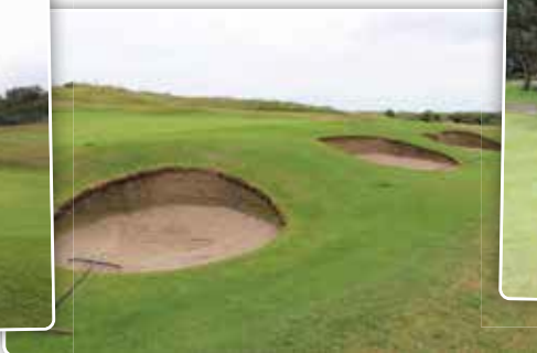
Bijzonder zijn de hoge randen van de zogeheten potbunkers die verstevigd zijn met trapsgewijs op elkaar gestapelde lapjes kunstzoden. Deze worden bij opbouw verstevigd met hard aangedrukt zand.
