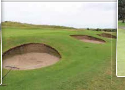
Une particularité: les bords élevés des soi-disant bunkers à pot sont renforcés de plaques en cascade de gazon artificiel empilées les unes sur les autres. Ceux-ci sont renforcés avec du sable pressé lorsqu'ils sont construits.
