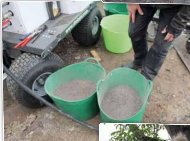
In de gaten wordt een mengsel van lava en samengestelde meststoffen geïnjecteerd.
