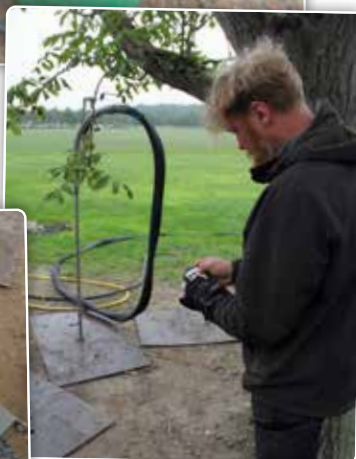
Stap 2: het injecteren van het granulaat op verschillende dieptes gebeurt met afstandsbediening.
