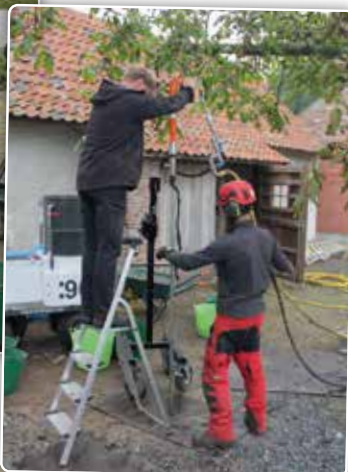
Stap 1 is een gat in de grond maken met de drillhamer en tegelijk water injecteren.
