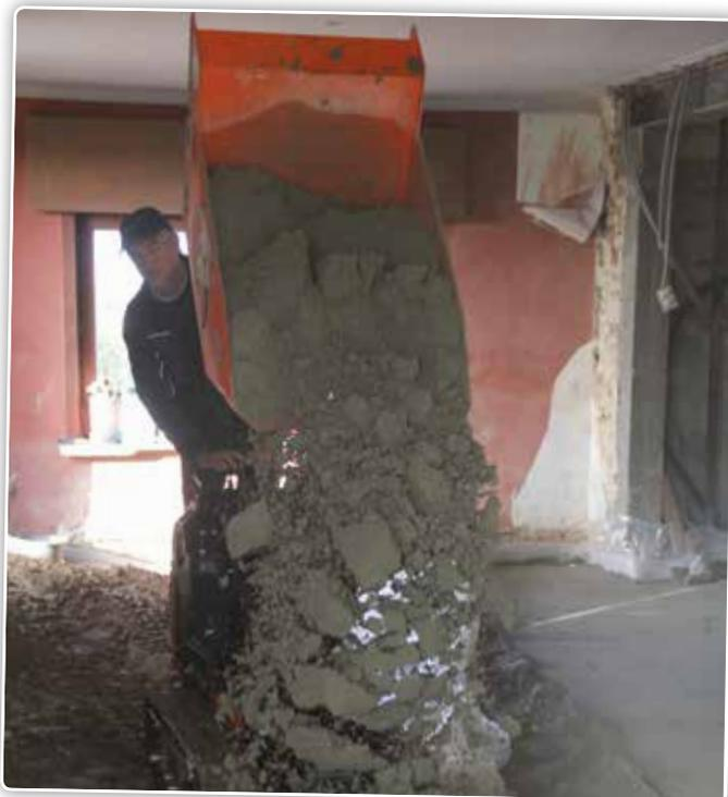
L'avantage de ce système de vidange surélevée est de pouvoir réaliser un tas plus haut en vidant des bricailons, du sable ou un autre produit au même endroit, plutôt que de réaliser plusieurs petits tas. La visibilité est bonne.
