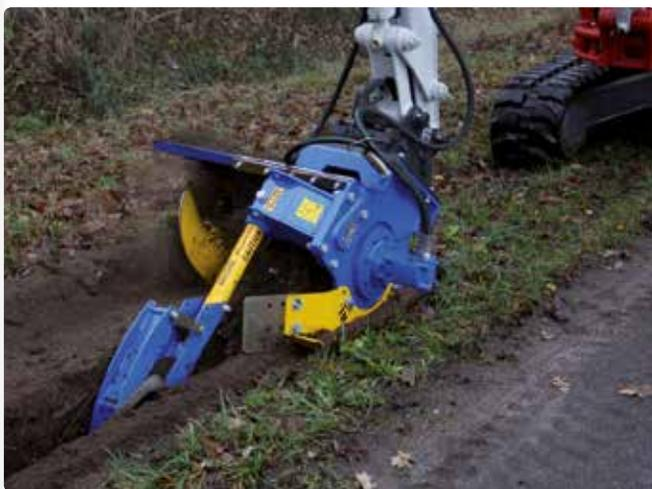
La société Verhoeven, qui importe la marque Takeuchi, a testé une nouvelle creuseuse de tranchées montée sur une mini-pelle, en collaboration avec la société de pose de câbles Atsa Infra Tel. La vitesse de travail de cet ensemble était d'environ 2 mètres par minute, contournement d'obstacles compris.
