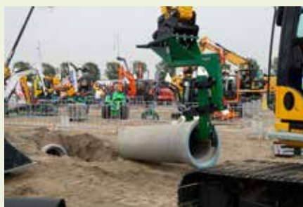
Over arbeidsbesparing en veiligheid gesproken: met deze nieuwe Nimatec kun je rioolbuizen oppakken, plaatsen en inschuiven. Dan het gat dichten en ten slotte de verdichtingsrol oppakken en aandrukken.
